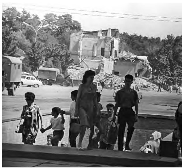
Ташкент, фрагмент разрушенного большого здания, 1966
