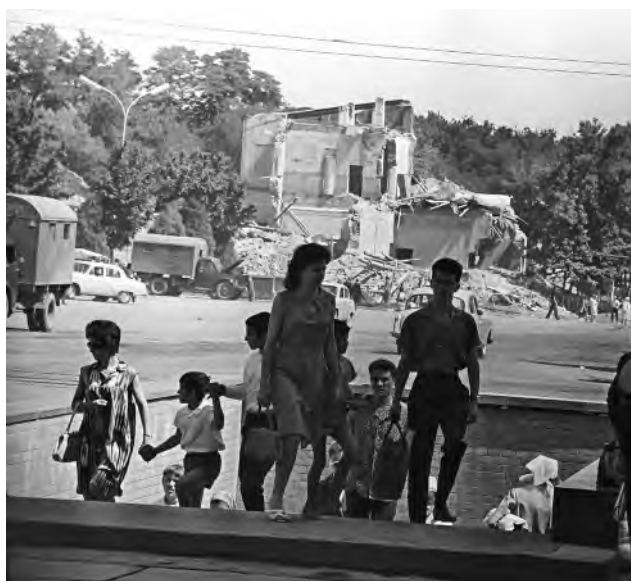
Ташкент, фрагмент разрушенного большого здания, 1966
