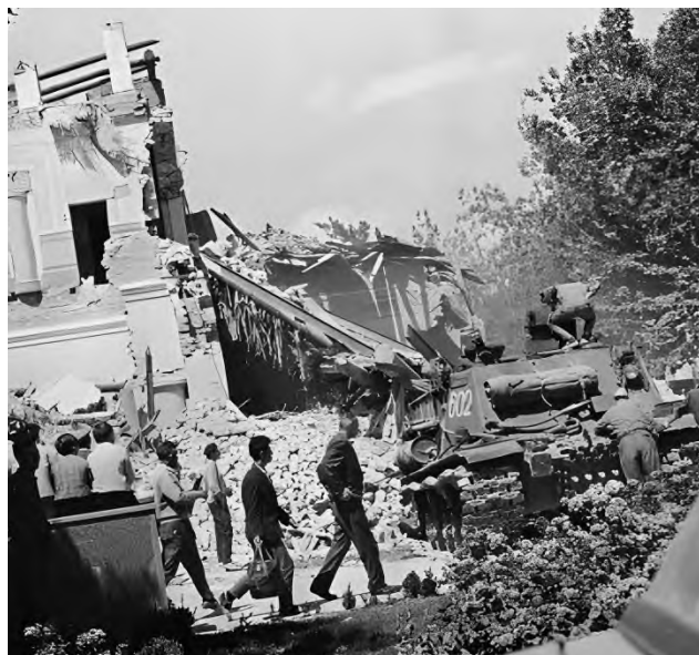
Ташкент, фрагмент разрушенного большого здания, 1966
