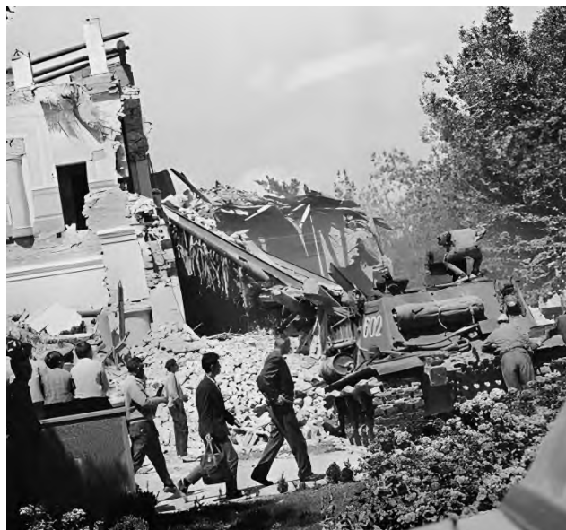
Ташкент, фрагмент разрушенного большого здания, 1966
